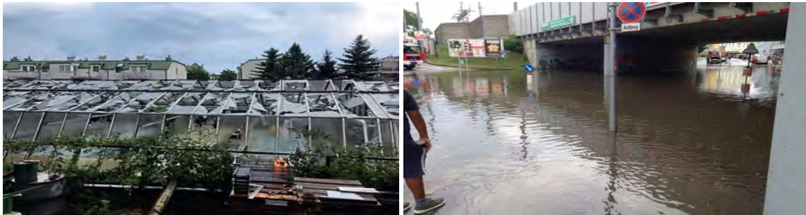
Abbildung 6: Hagelschäden in Mannswörth (Quelle: www.hagel.at ) und Überflutung der Schnellbahnunterführung in Wien-Atzgersdorf am 10. Juli 2017 (Quelle: www.meinbezirk.at )
