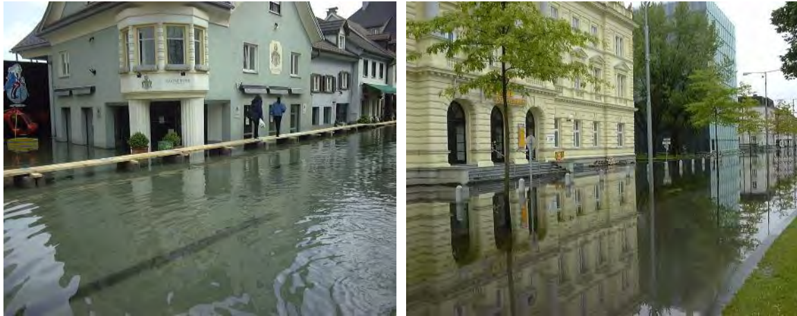
Der hohe Wasserstand des Bodensees 1999 verursachte Überflutungen in Bregenz (Fotos: C. Mathis)
