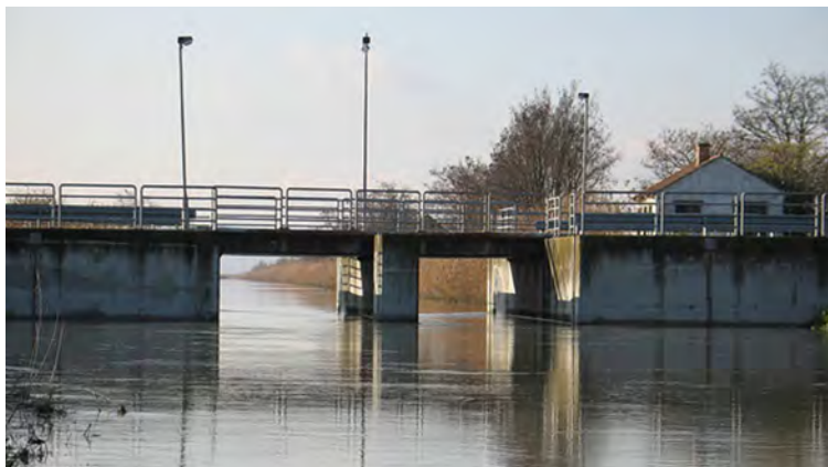
Abbildung 8: Wehranlage in Mekszikópuszta (Quelle: Hydro Burgenland)
