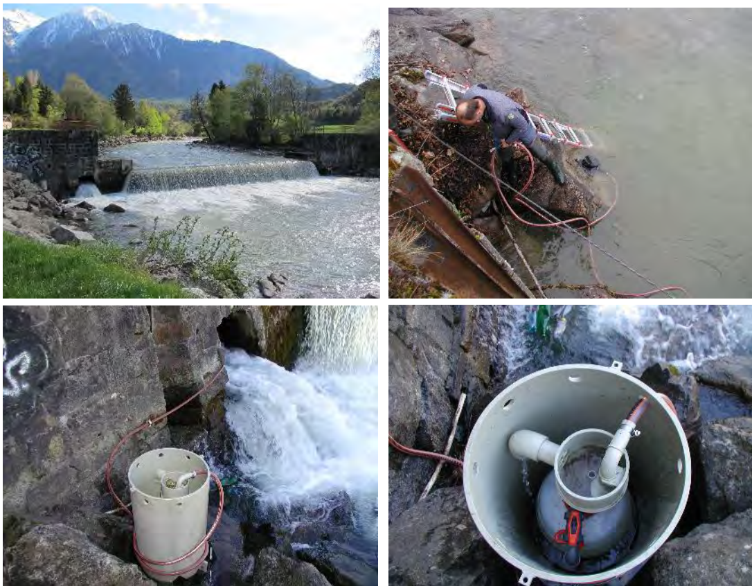
Abbildung 11: oben – das linke Bild zeigt die Messstelle an der Öztaler Ache im Bereich des Absturzes, orographisch rechts bei der Dotieröffnung; oben – das rechte Bild zeigt die Montage des Einlauftrichters und Zuleitung durch die Hydrometrische Werkstätte (HD Tirol) bei Niederwasser; der Einlauftrichter mit Schlauch ist in Bildmitte knapp über dem Wasserspiegel ersichtlich; unten – das linke Bild zeigt den Standort des Probennehmers neben der Dotationsöffnung; unten – rechtes Bild: Probennehmergefäß TU Wien im Detail (Quelle: HD Tirol)
