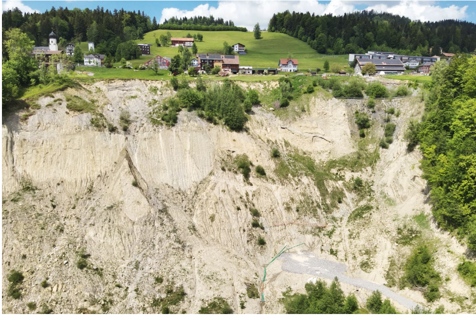
Rutschung in der Gemeinde Doren
