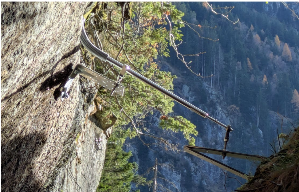
Monitoring einer lokalen Instabilität mittels Rissmesser
