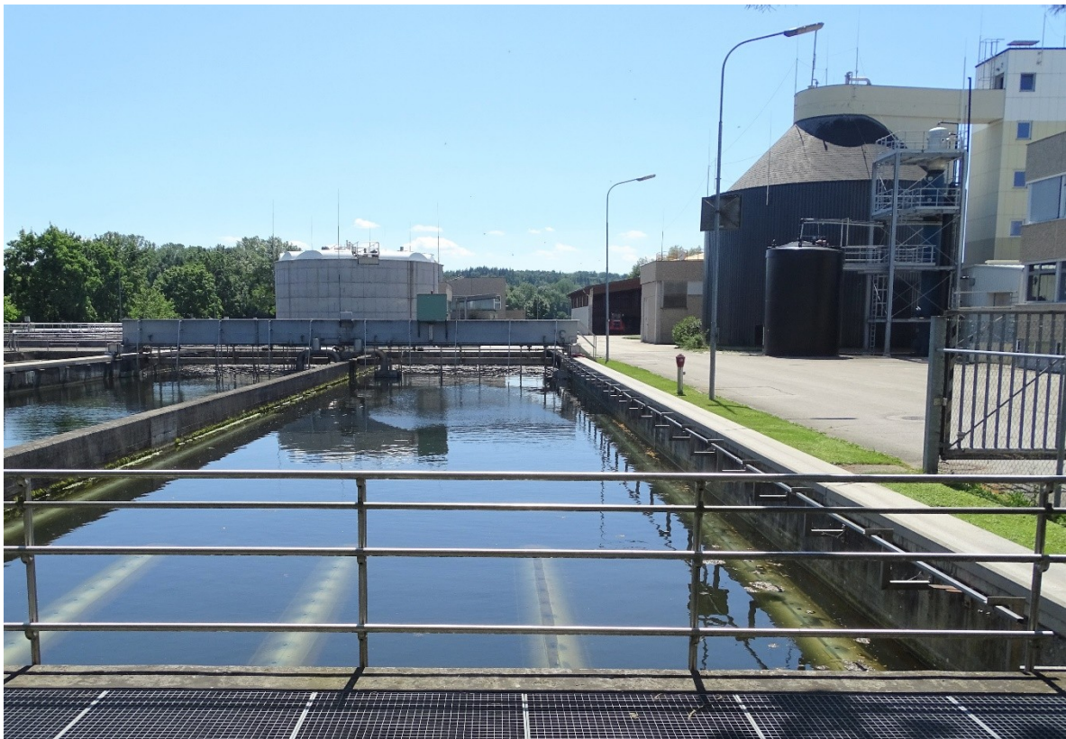
Kommunale Kläranlage ARA Trattnachtal, © BMLUK/Katharina Lenz.
