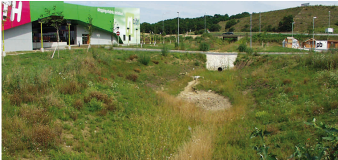
Abbildung 45 Extensiv gepflegte Retentionsmulde in Mistelbach
