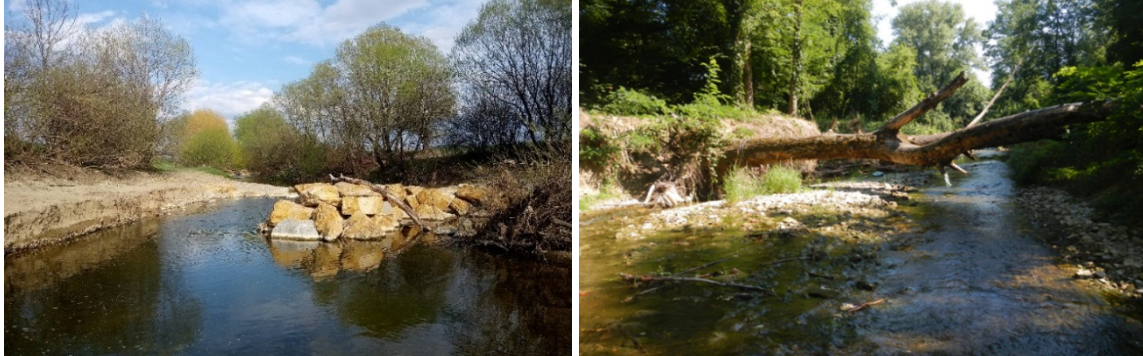
Abbildung 17 Hohe Steinbuhne mit Ufererosion gegenüber und resultierendem tiefen Kolk (Mank, NÖ). Struktureicher Abschnitt am Laabenbach nach umgesetzter Renaturierung (NÖ)
