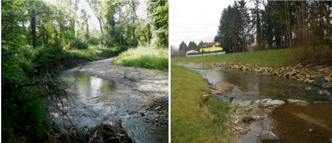
Abbildung 6 Kompaktes MW-Bett und Beschattung (links). Überbreites MW-Bett, flach überströmt ohne höheren Uferbewuchs, z.T. Verwendung dunkler Wasserbausteine (rechts)
