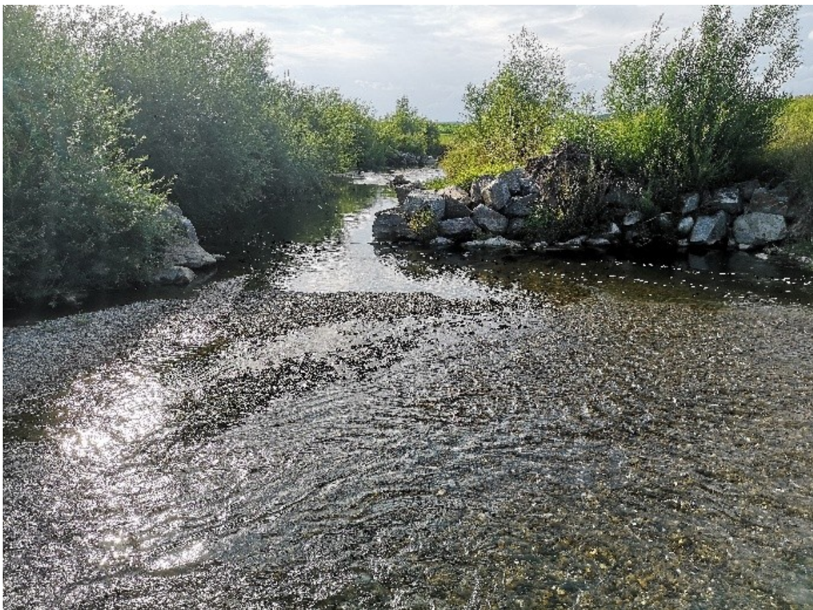
Abbildung 18 Buhne mit Kolk am Bühnenkopf und Kiesinsel/Furt flussab (Melk, NÖ)
