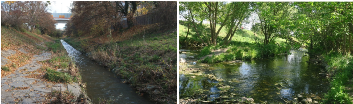
Abbildung 9 Liesing – Hart verbauter Abschnitt mit Sohlpflasterung. Revitalisierter Bereich (2005) am Liesingbach
