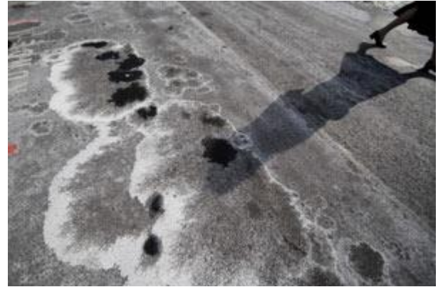
Abb. 2. Salzausblühungen am Straßenrand bei trockenem Winterwetter (Foto: http://derstandard.at/ )
