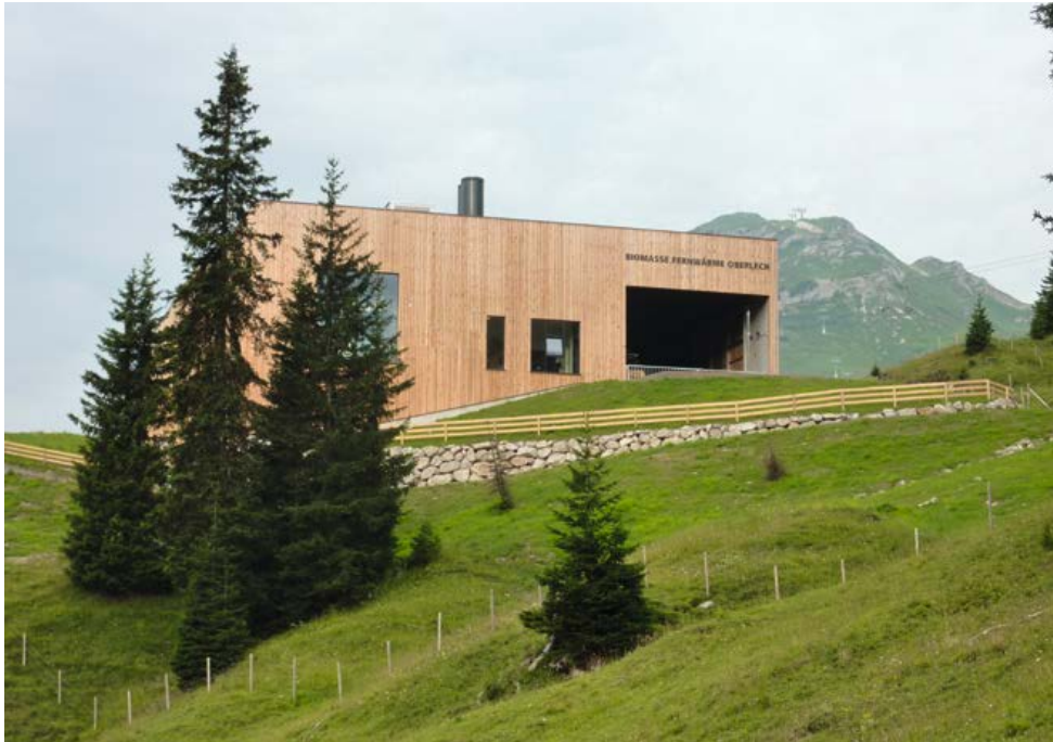
Heizhaus Biomasse Fernwärme Oberlech
