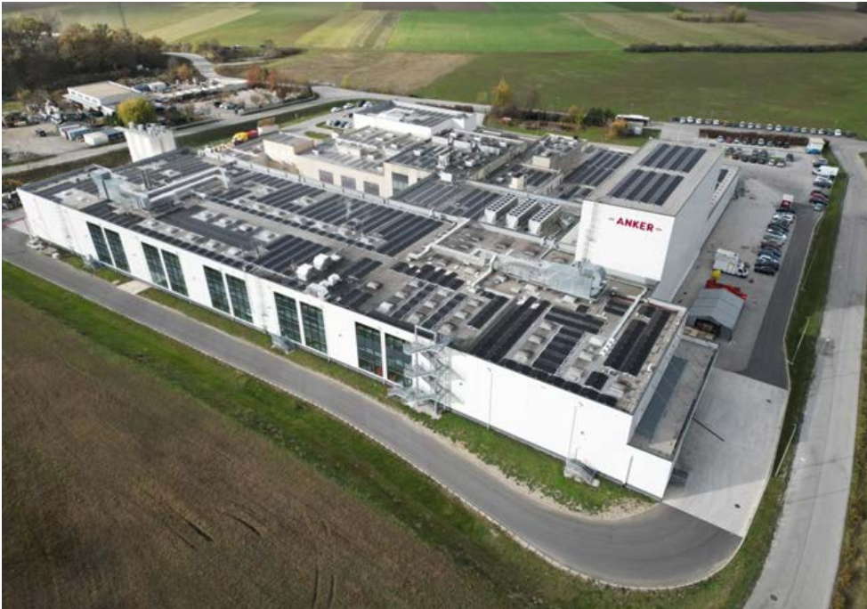
Luftaufnahme des neuen Produktionsstandorts in Lichtenwörth, NÖ
