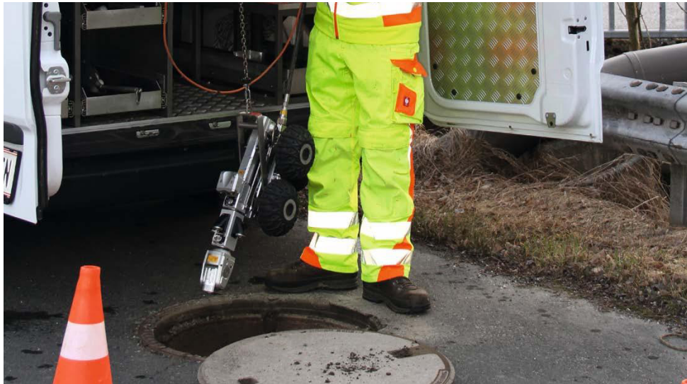
Einsetzen der Kamera zur Befahrung der Kanäle zur Zustandserhebung
