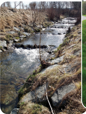
Fischtreppe Wulka (Antau)
