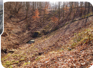
Rückhaltebecken Kleinhöfleiner Bach
