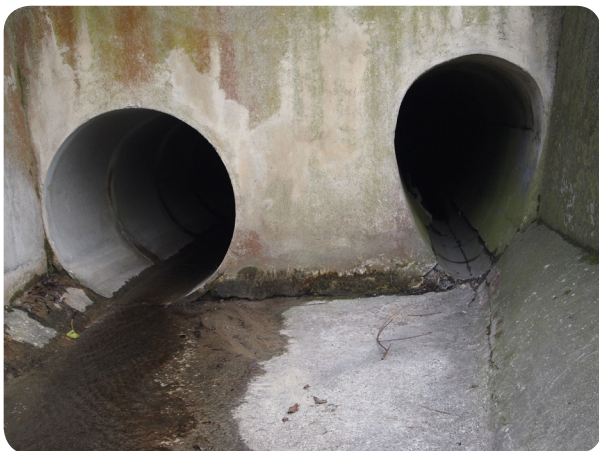
Kreisprofil (links) – Eiprofil (rechts)
