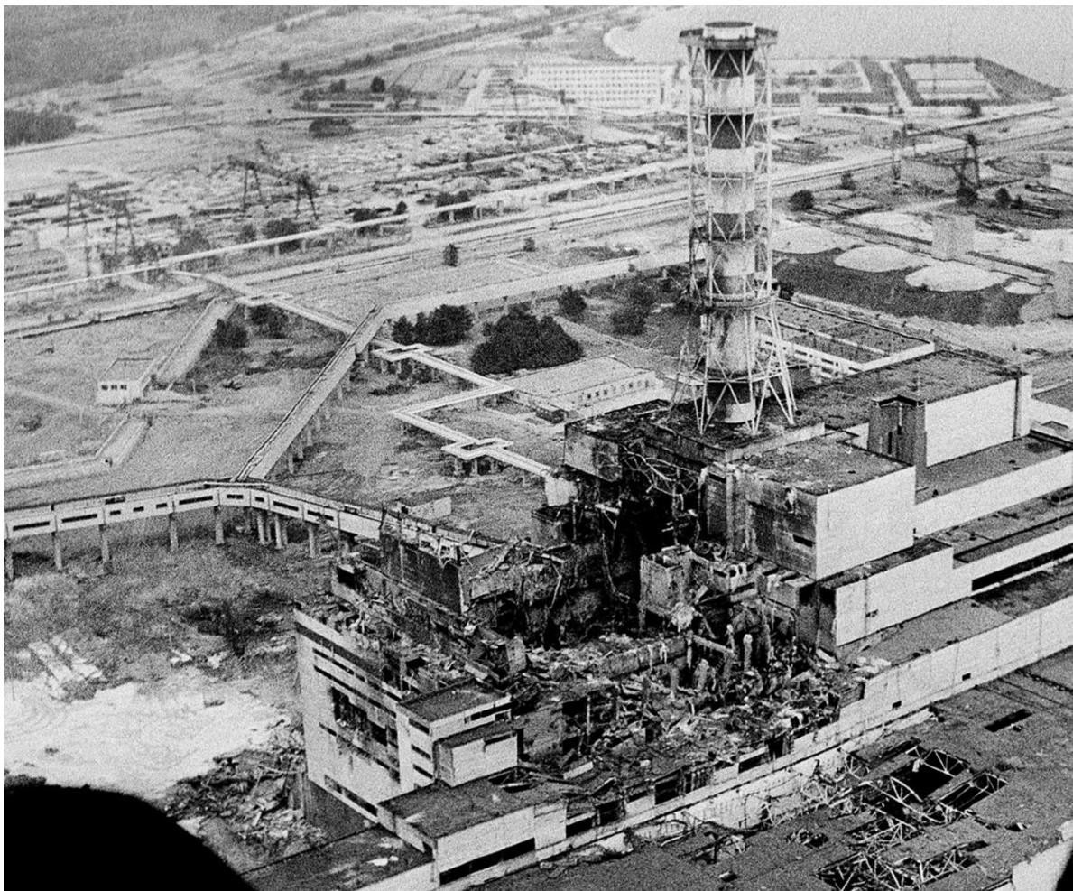
Abbildung 1 Der zerstörte Block 4 (links) und Block 3 (rechts) des Kernkraftwerks Tschernobyl
