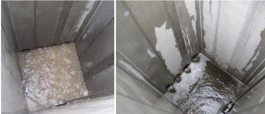
Abbildung 92: Regenereignis vom 10.06.2012 der GSA A2, links: Filterablauf im Dränschacht um 19:10 Uhr, rechts: Filterablauf im Dränschacht während der Beprobung um 20:00 Uhr
