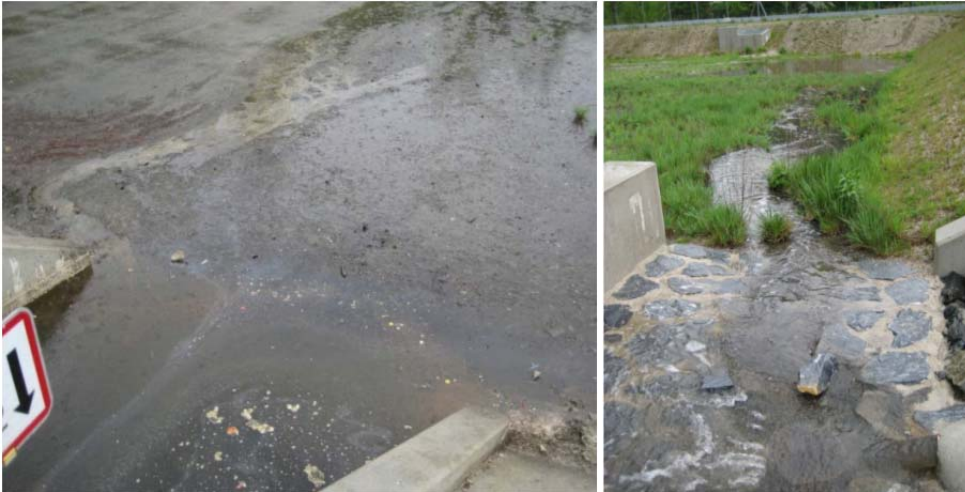
Abbildung 86: GSA A2, links: Zulauf Verteilerbauwerk (Leichtstoffabscheideraum, rechts: Verteilerbauwerk bei Drosselabfluss
