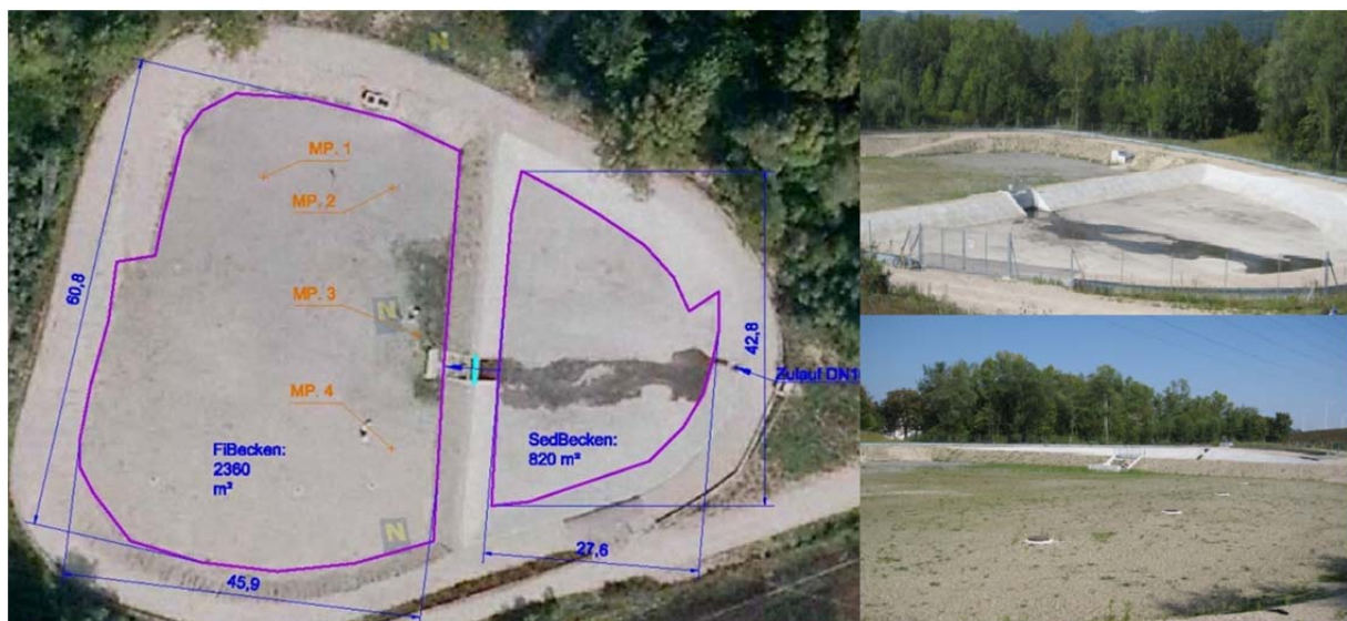
Abbildung 12: GSA A2, links Übersicht der Anlage (Luftbild: NÖ ATLAS, 2012) modifiziert, rechts oben: Sedimentationsbecken, rechts unten: Filterbecken
